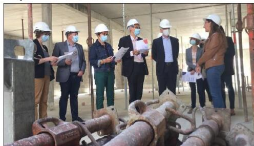
La visite de chantier a permis de visualiser les espaces, qui seront le plus possible tournés vers l'extérieur. Photo LBP/C. G.
