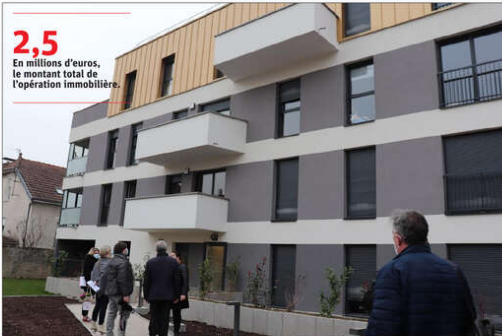
La résidence Clément-Janin compte quatorze logements alimentés par un système de chauffage et de production d'eau chaude « très performant ». Photo LBP/N. D.
