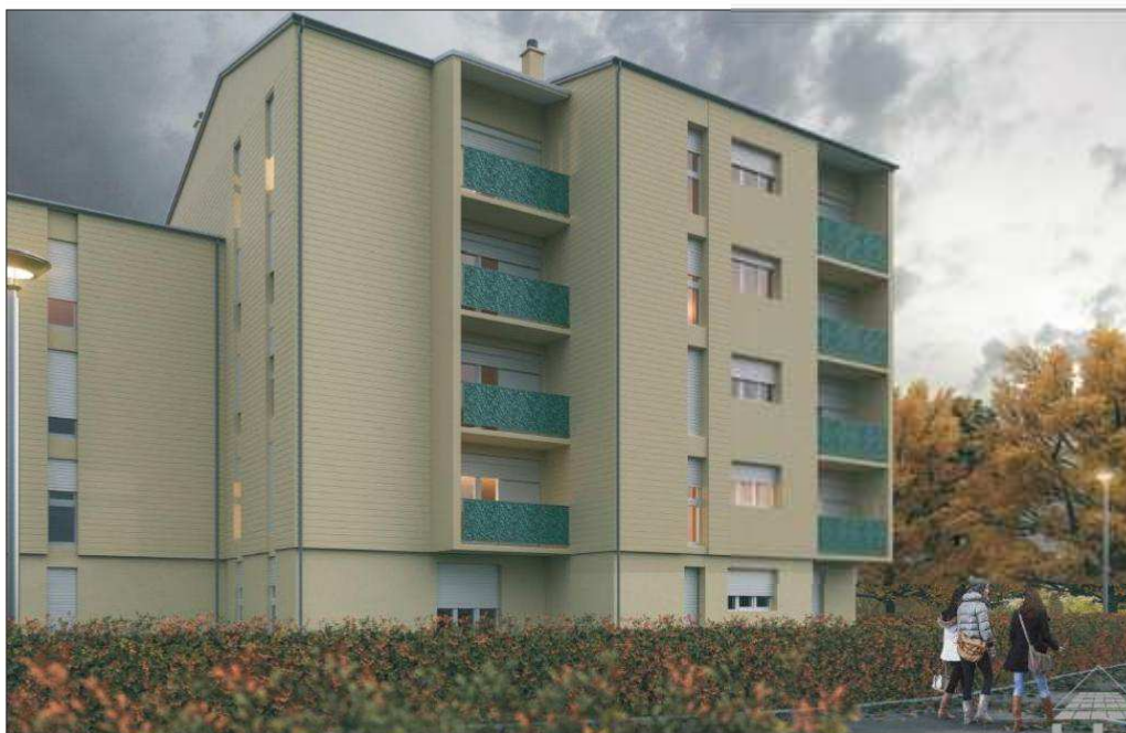
À l'issue de plusieurs mois de travaux, menés par le bailleur social Habellis, les cent logements de la résidence des Argillats devraient être rénovés, donnant un nouveau visage à ce quartier. Photomontage cabinet HBI
