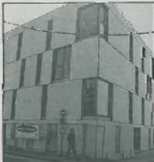
Les ouvriers vont maintenant aménager la partie extérieure du bâtiment. Photo N. D.
